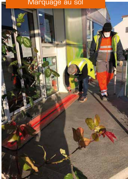
Marquage au sol
