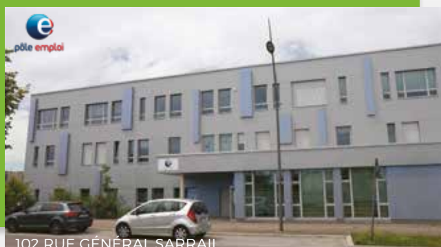
102 RUE GÉNÉRAL SARRAIL
