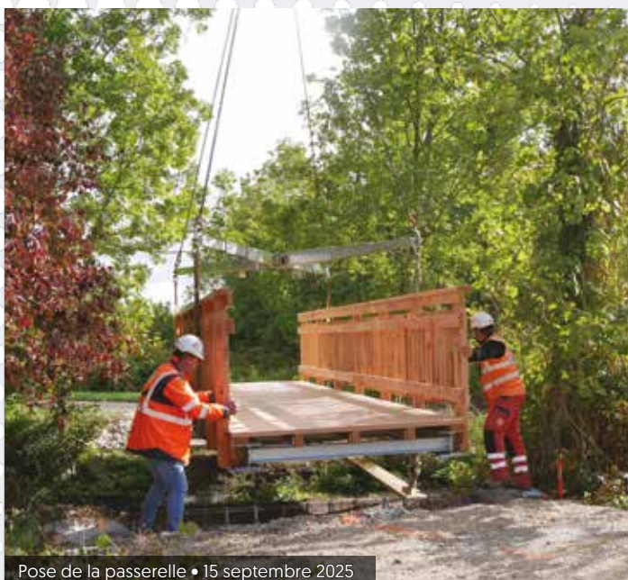
Pose de la passerelle • 15 septembre 2025
