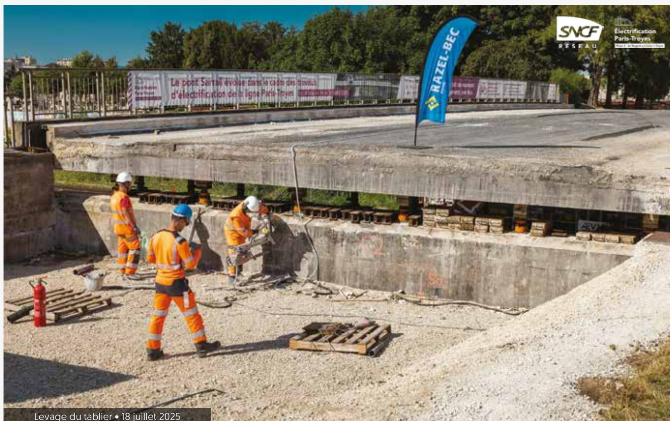
Levage du tablier • 18 juillet 2025
