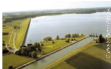
Digue de la Morge
