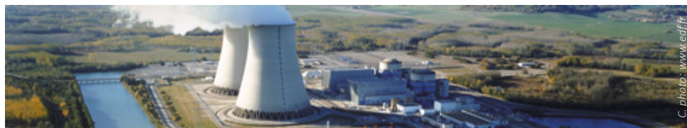
La centrale nucléaire de Nogent-sur-Seine
