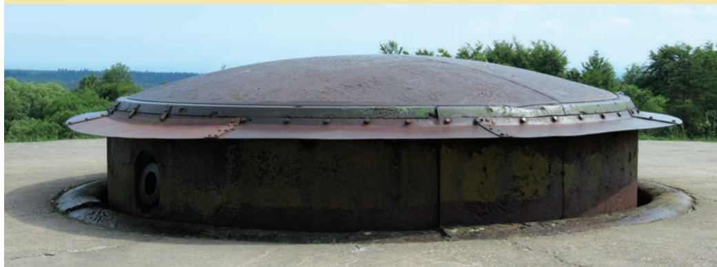
Tourelle au fort de Douaumont.
