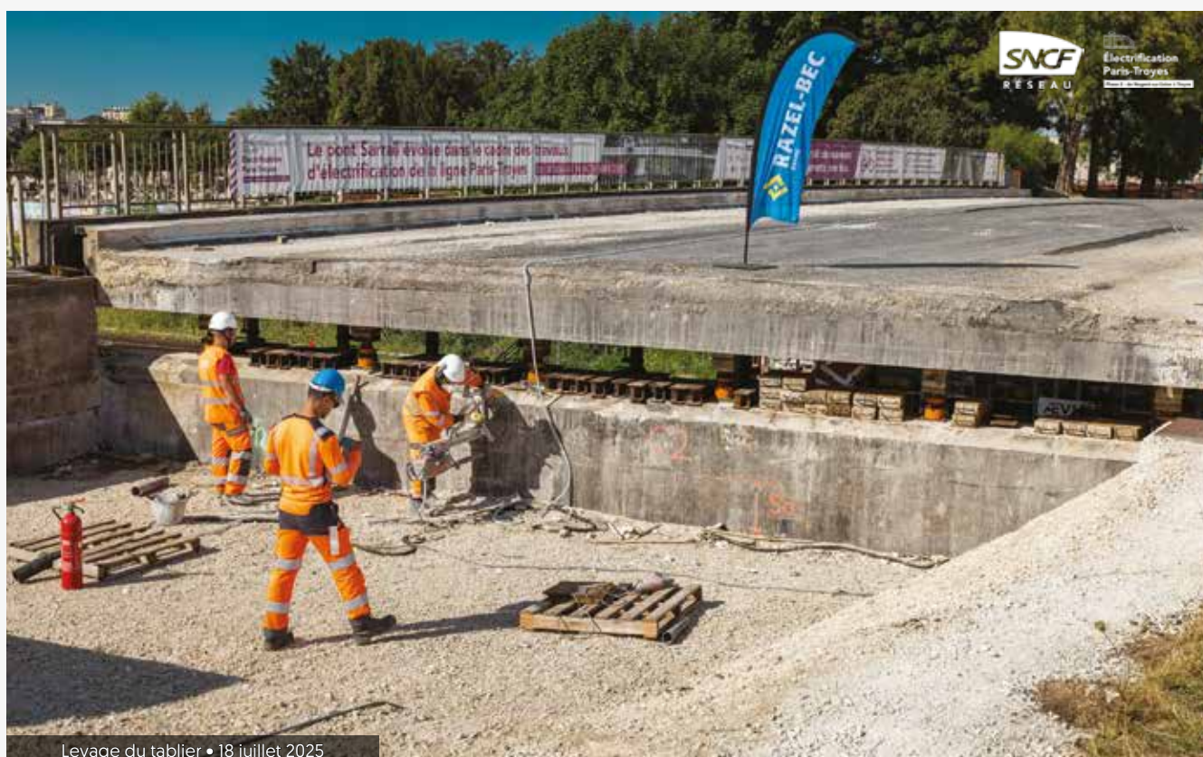
Levage du tablier • 18 juillet 2025
