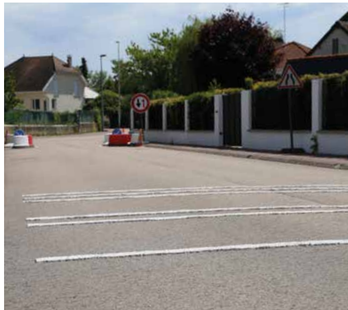
SÉCURISATION DES RUES CHASSEIGNE ET FERRY
